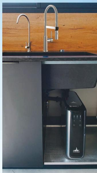
L'AQUALAUGIL® BOX ne dispose pas de condition particulière d'installation. Il peut être placé dans n'importe quel position sans que cela intervienne sur la production d'eau car celle-ci se fait en direct. Vous pouvez donc le positionner : à plat, sur la hauteur, sur la largeur.
